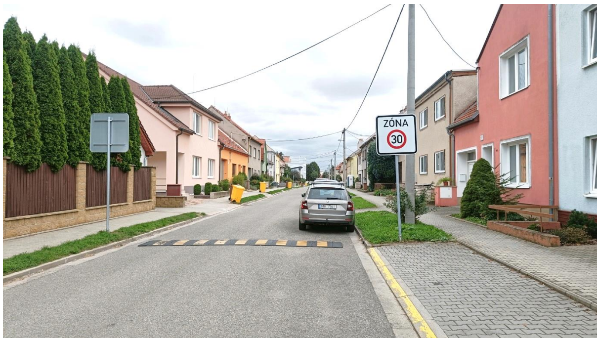
Obr. 20: Šířka vozovky v současném dopravním režimu neumožňuje legální parkování. Vedle zaparkovaného vozidla nezůstává volná šířka 3 m pro každý směr jízdy.
