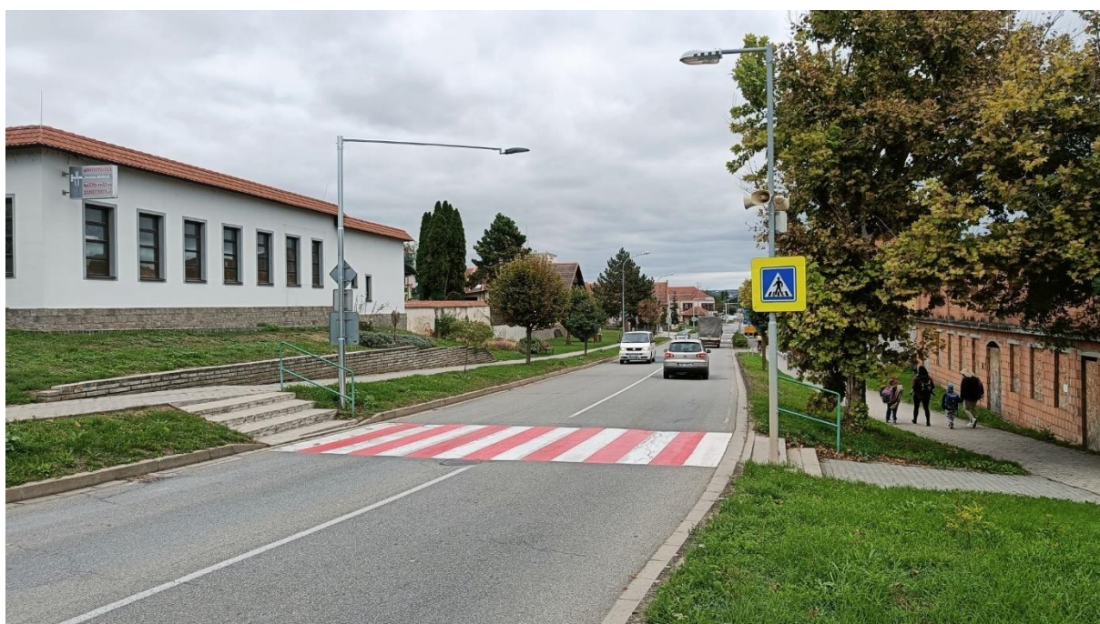
Obr. 7: Problematický přechod pro chodce v Nádražní ulici. Schody nesmí podle normy vést přímo do přechodu pro chodce. Přechod pro chodce by současně měl být zcela bezbariérový.
