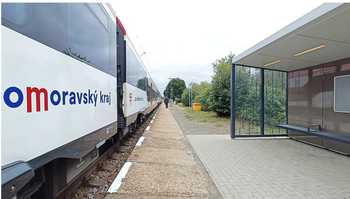
Obr. 10: Železniční zastávka Újezd u Brna s nízkou nástupní hranou, která neumožňuje bezbariérový nástup.
