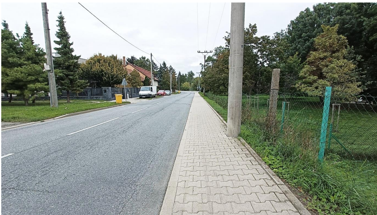
Obr. 5: Úzký chodník ve Štefánikově ulici – méně než 1,5 m. Pokud je chodník přimknutý k vozovce, kde je rychlost dopravy větší než 30 km/h, musí být minimální šířka chodníku 2,0 m.
