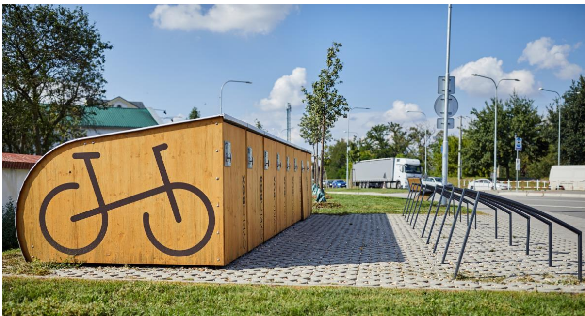
Obr. 13: Cykloboxy a stojany vhodné k uzamčení kola na nádraží v Židlochovicích, zdroj: Antonín Kapran
