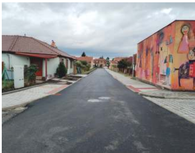
Rozšíření komunikace ul. Palackého
