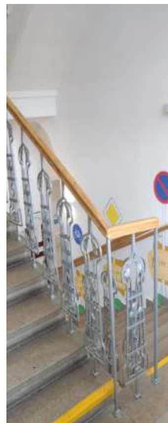
Zábradlí po renovaci
