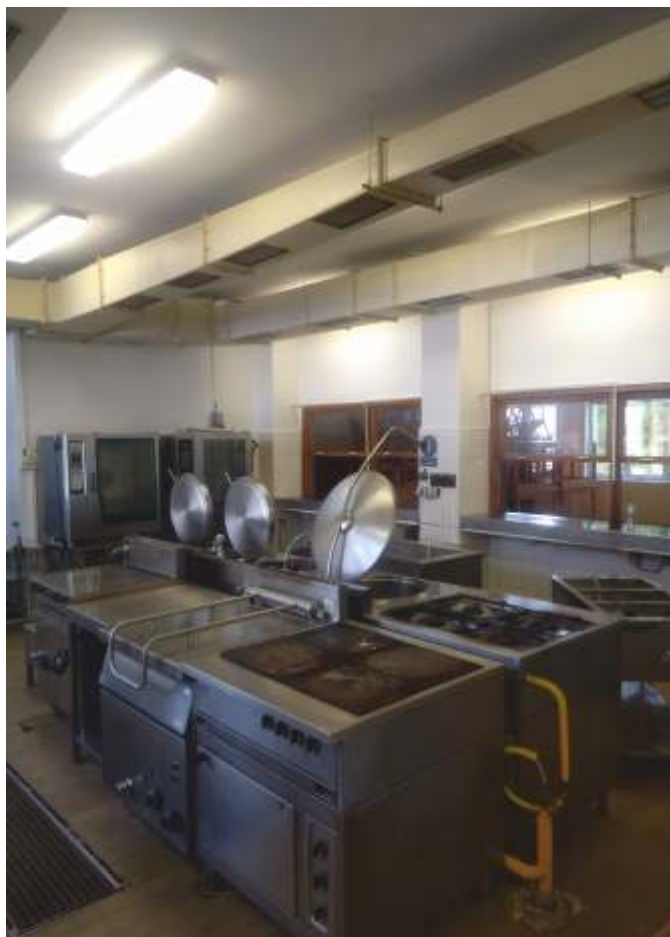
Kuchyně před rekonstrukcí
