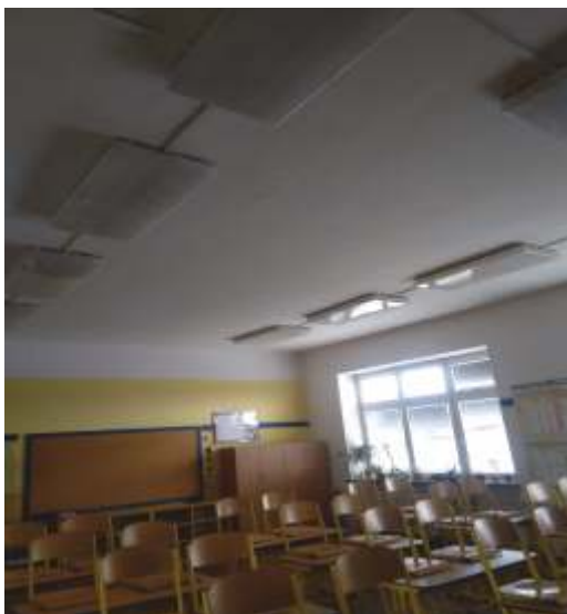
Učebna před rekonstrukcí
