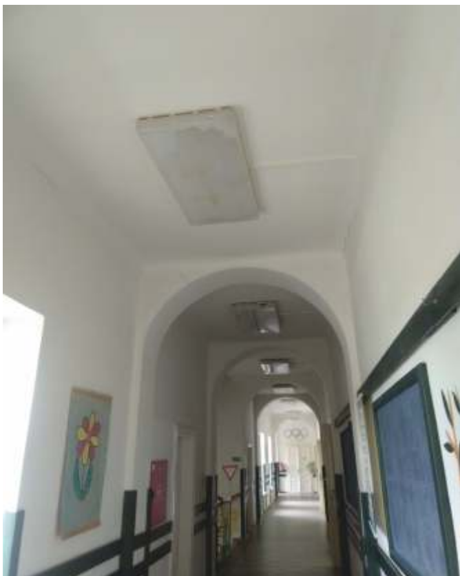
Chodba před rekonstrukcí
