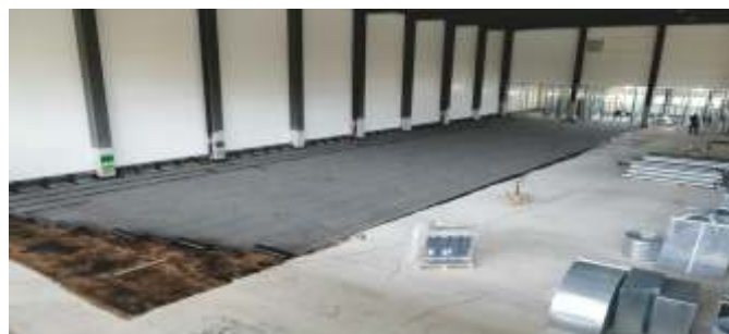
Pokládání hydroizolace
