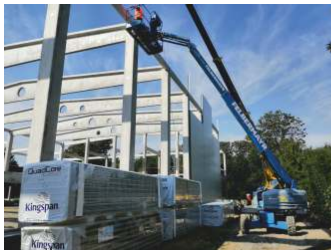
montáž panelů opláštění
