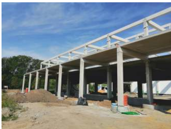
skelet stavby z jižní strany
