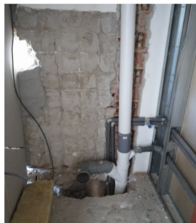
Nové rozvody pro toaletu v 1NP
