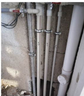
Nové rozvody a odpady
