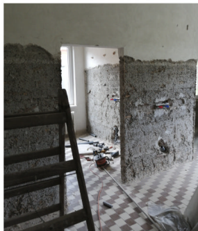
Nové rozvody vody v kuchyni
