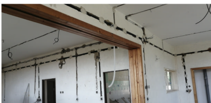
Nové rozvody elektriny a zokruhování teplé vody
