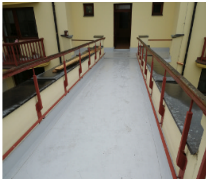
Střecha spojovací chodby v DPS - tzv. krček
