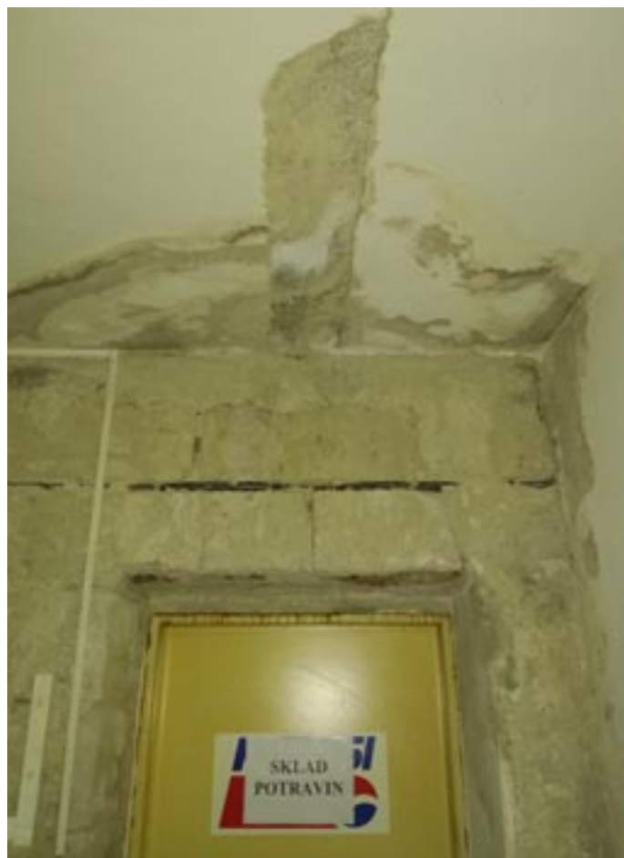
Prostor kuchyně, vstup do skladu potravin
