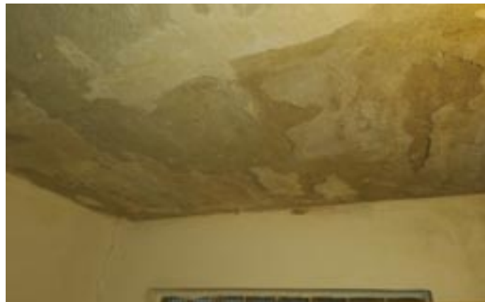
Prostor kuchyně, místnost skladu potravin
