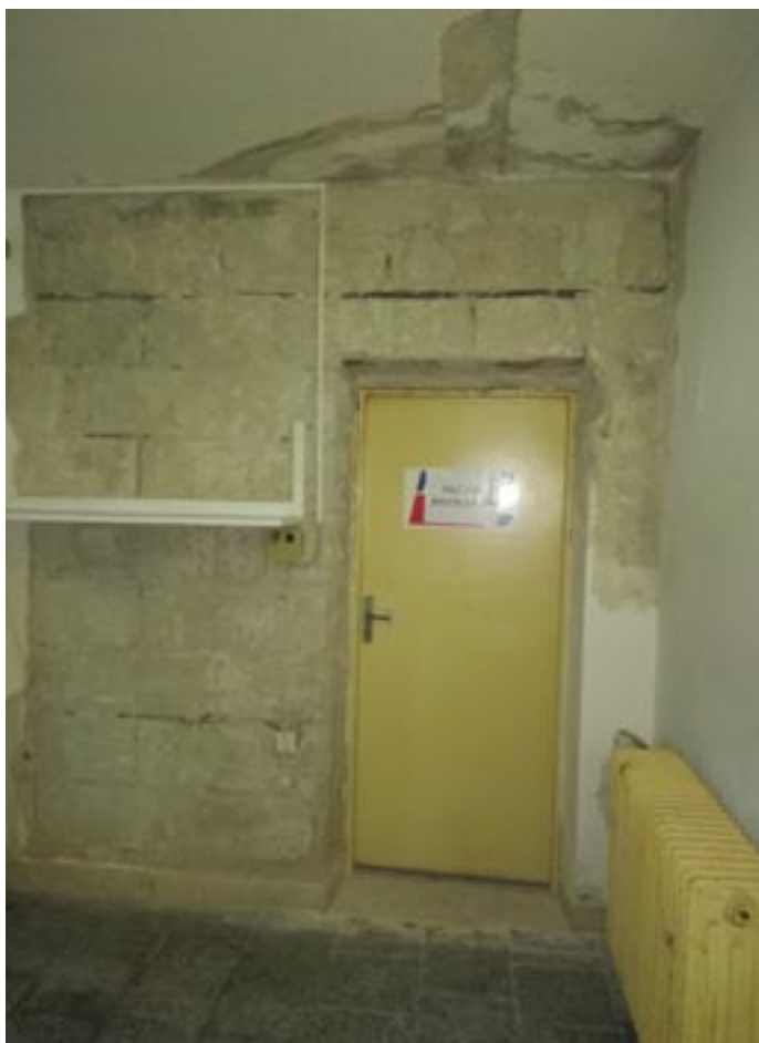
Prostor kuchyně, vstup do skladu potravin
