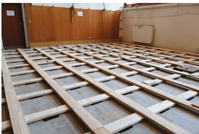
Montáž nového roštu
