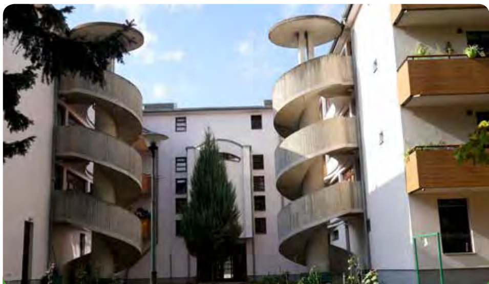
Penzion pro seniory nesl i přes nízké stáří stopu nedostatků. Byla zapotřebí kupř. nová kotelna, zbudovaly se nové byty a nedávno obložení balkónů. O postavení penzionu se zasloužil starosta František Kotolan.
