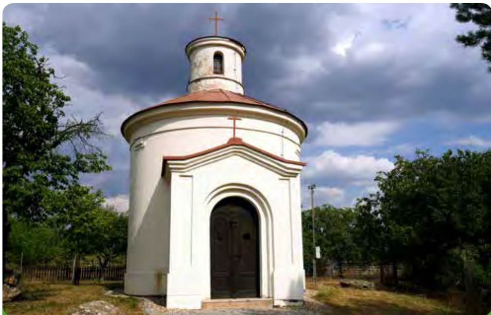
Kaple sv. Antonína Paduánského, majetek římskokatolické farnosti. Kompletní generální opravu provedlo a zaplatilo Město Újezd u Brna včetně odvlhčení stavby.
