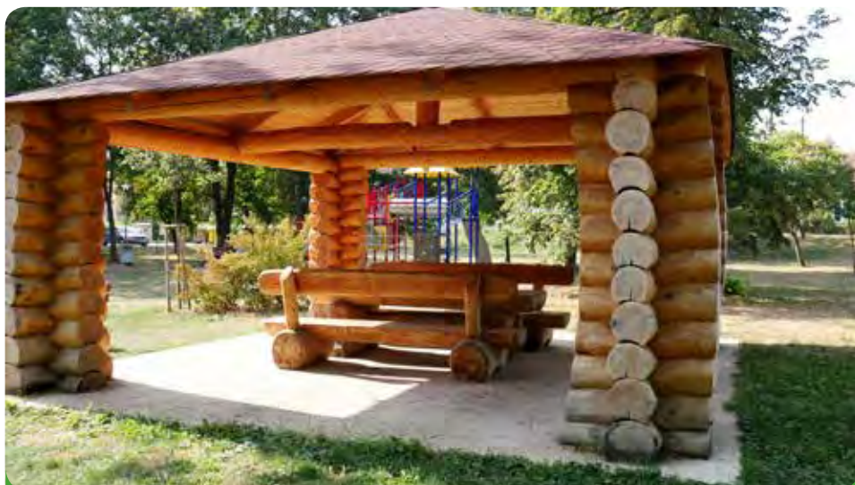
Takovéto sruby máme dva. Někteří nemoudří měli připomínky, že je to zbytečně hrubé, ale tyto dva sruby přežily a přežijí jakékoliv vandalství, protože se přebrousí a jsou jako nové. Autorem těchto srubů je Jan Konečný.
