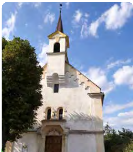
Evangelický kostel užívaný dvěma církvemi, kdy Církev československá husitská je v nájmu. Město Újezd u Brna dotačně zabezpečilo plynofikaci, apsidu se sociálním zázemím, novou střechu a jiné.
