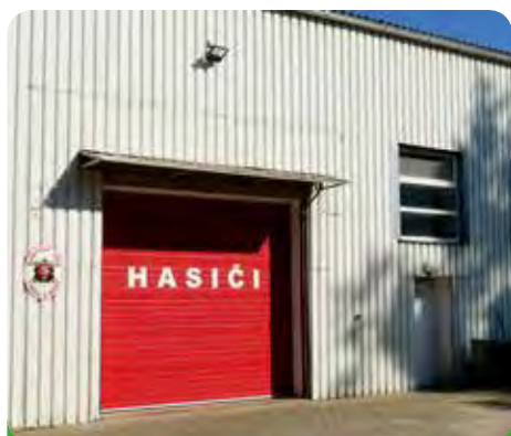
Velice nedostačující hasičská zbrojnice byla pod radnicí. Šokem bylo, když starosta rozhodl přemístit hasičskou zbrojnici na Štefánikovu ulici. Dnes je vyhovující.
