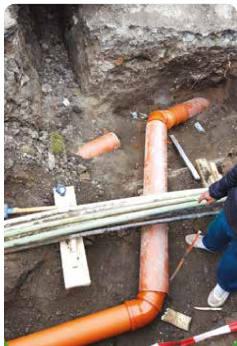
Náročná stavební práce při křížení plynovodu
