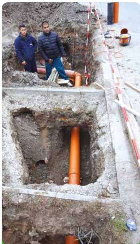
Křížení plynovodních přípojek
