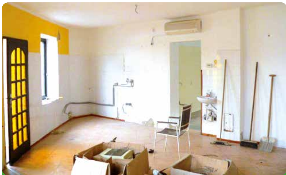
Rekonstrukce bývalé cukrárny
