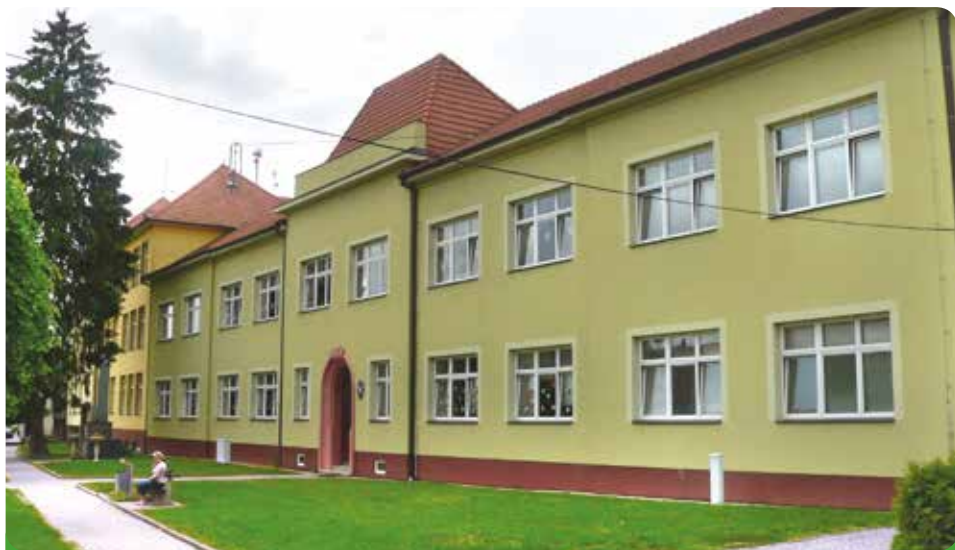
Základní škola po generální stavební rekonstrukci – střecha, zateplení pláště, okna, nová kotelná. Je připraven projekt na kompletní rekonstrukci elektrických rozvodů a zbudování kvalitní jazykové třídy, 30.813.330,50 Kč
