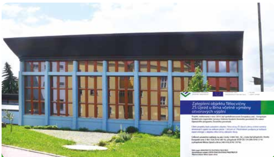
Nově zrekonstruovaná tělocvična – pohled z dvorního traktu ZŠ. Výměna oken s elektrickým otevíráním, zateplení pláště – odstranění zavlhání, 25.369.722,20 Kč
