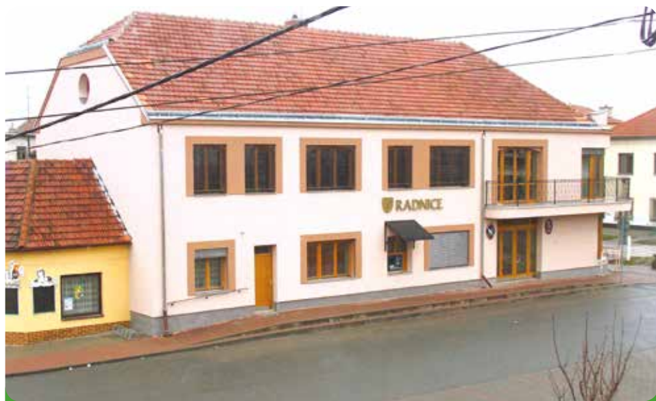
Výměna oken, zateplení, nová fasáda radnice
