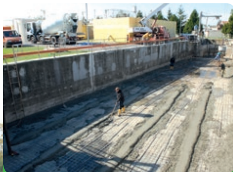
Betonáz dešťové zdrže ČOV
