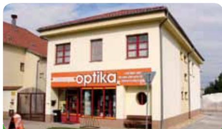
Budova bývalé Telefoniey 02
