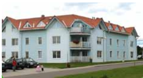
Bytový dům B na ul. Rozprýmové
