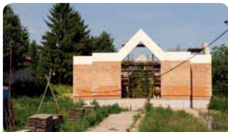
Rozestavená stavba obřadní síně
