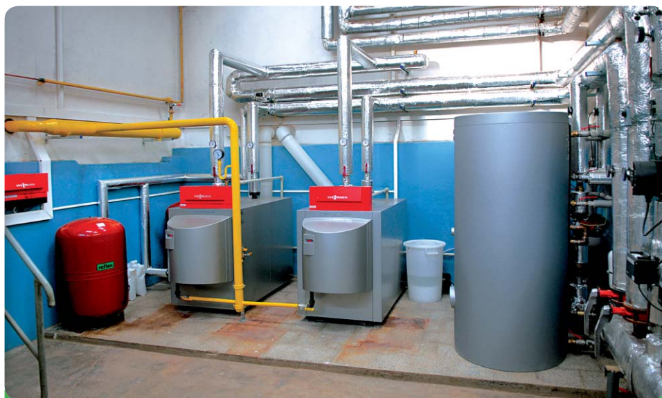
Kotelna školy byla vybavena novými kotly Viessmann
