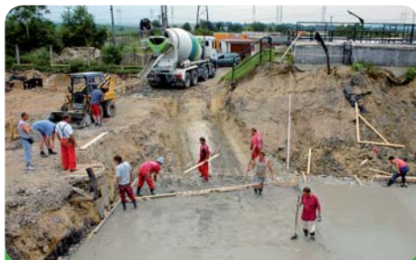
Už stavíme ČOV
