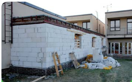
Generální oprava školy - nová okna a jiné
