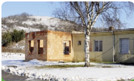
Zde ještě chybí střecha
