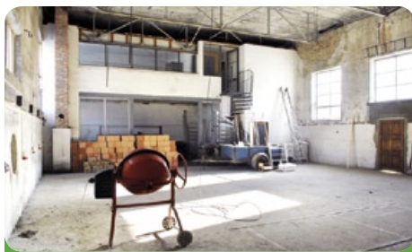
V zimě jsme tuto halu opravili
