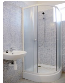
Sociální zařízení v ubytovně
