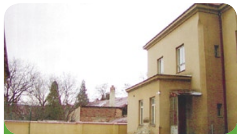
Pohled na školu před opravou v roce 1998
