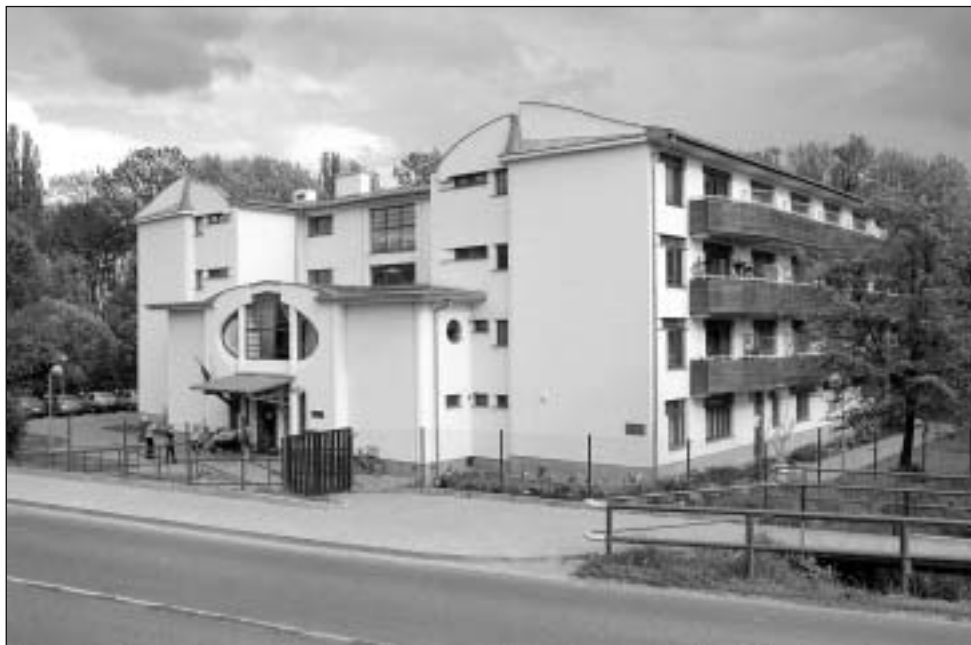
Penzion pro důchodce na Štefánikově ulici
