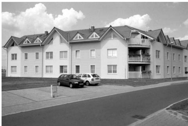
Výstavba 20 bytových jednotek – blok „B“
