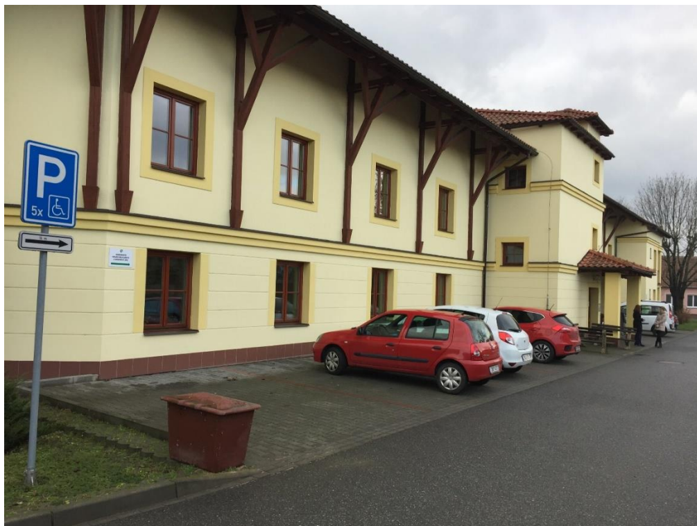
Obr. 38 – Dům s pečovatelskou službou, ulice Rybářská, možnost kolmého parkování po dvou stranách budovy, pět stání je vyhrazeno pro osoby s omezenou schopností pohybu a orientace (dopravní značka IP12)
