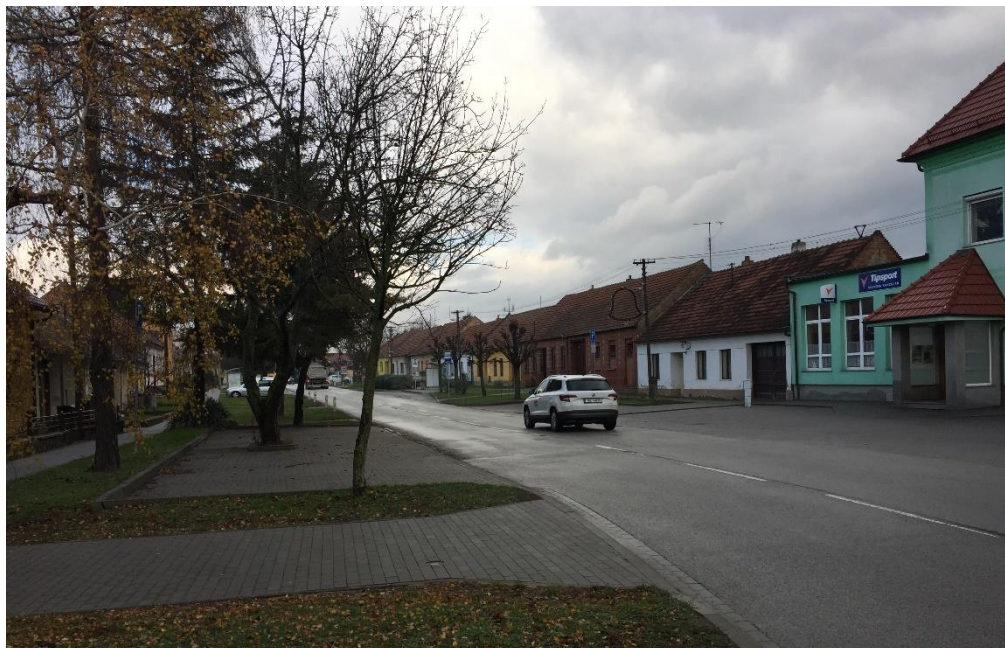
Obr. 34 – Pohled ze západního směru na ulice Rychmanovská, silnice II/418
