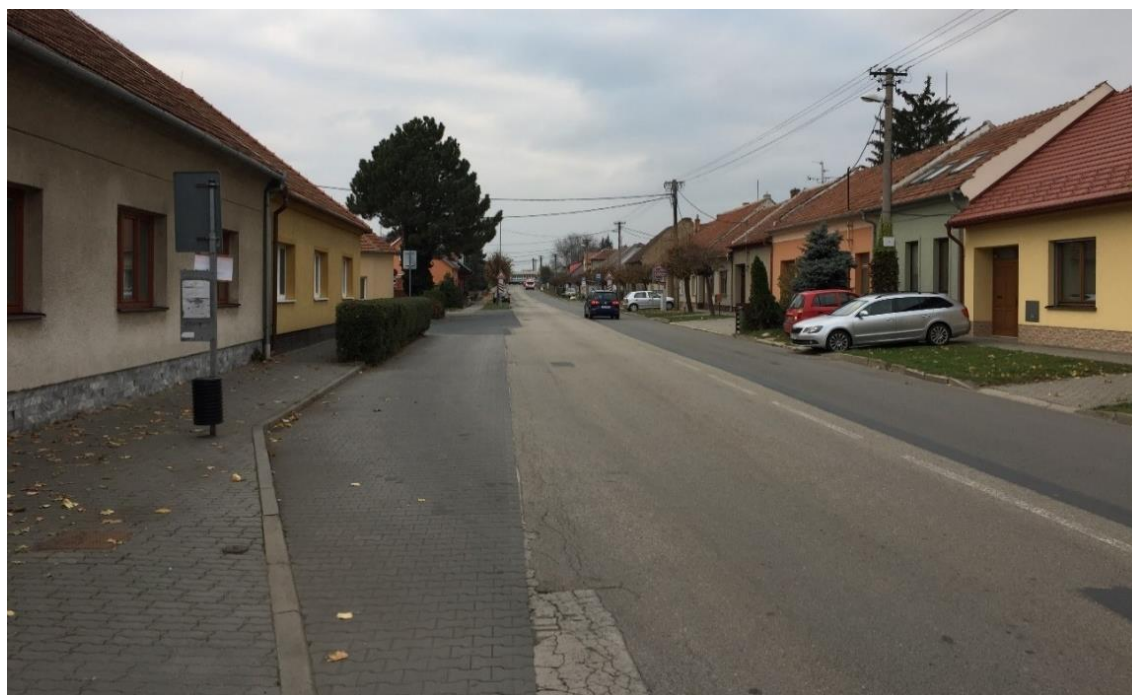
Obr. 88 – Zastávka revoluční, zastávkové stanoviště pro dopravní směr Brno → Újezd u Brna
