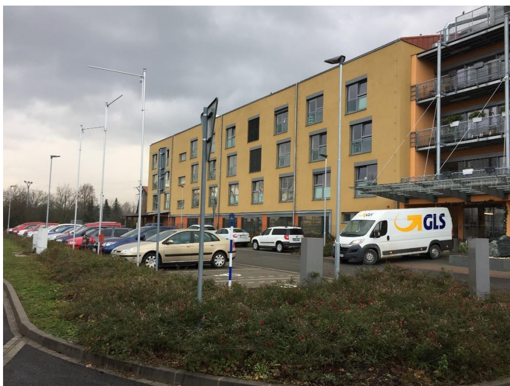
Obr. 37 – Pohled na parkoviště před Domovem u Františka, ulice Rybářska
