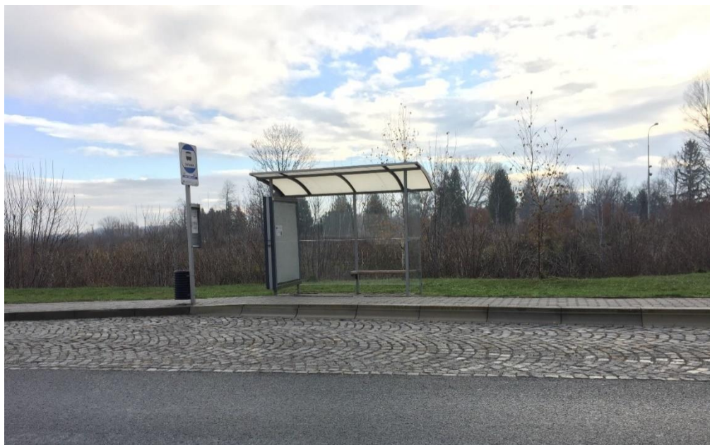
Obr. 94 – Zastávka penzion, zastávkové stanoviště pro dopravní směr Brno → Újezd u Brna
