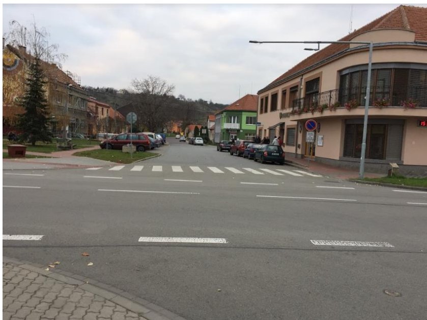
Obr. 76 – Přejechod pro chodce na vedlejší komunikaci
