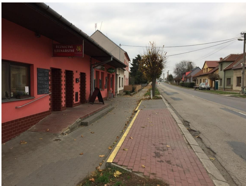
Obr. 3 – Podélné parkovací stání před budovou řeznictví, uzenářství na ulici Nádražní
