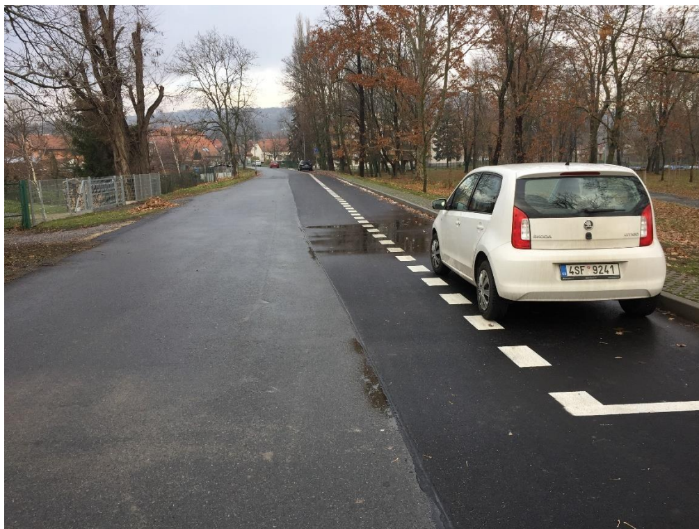
Obr. 27 – Parkovací pás vyznačený vodorovným dopravním značením na ulice U parku
