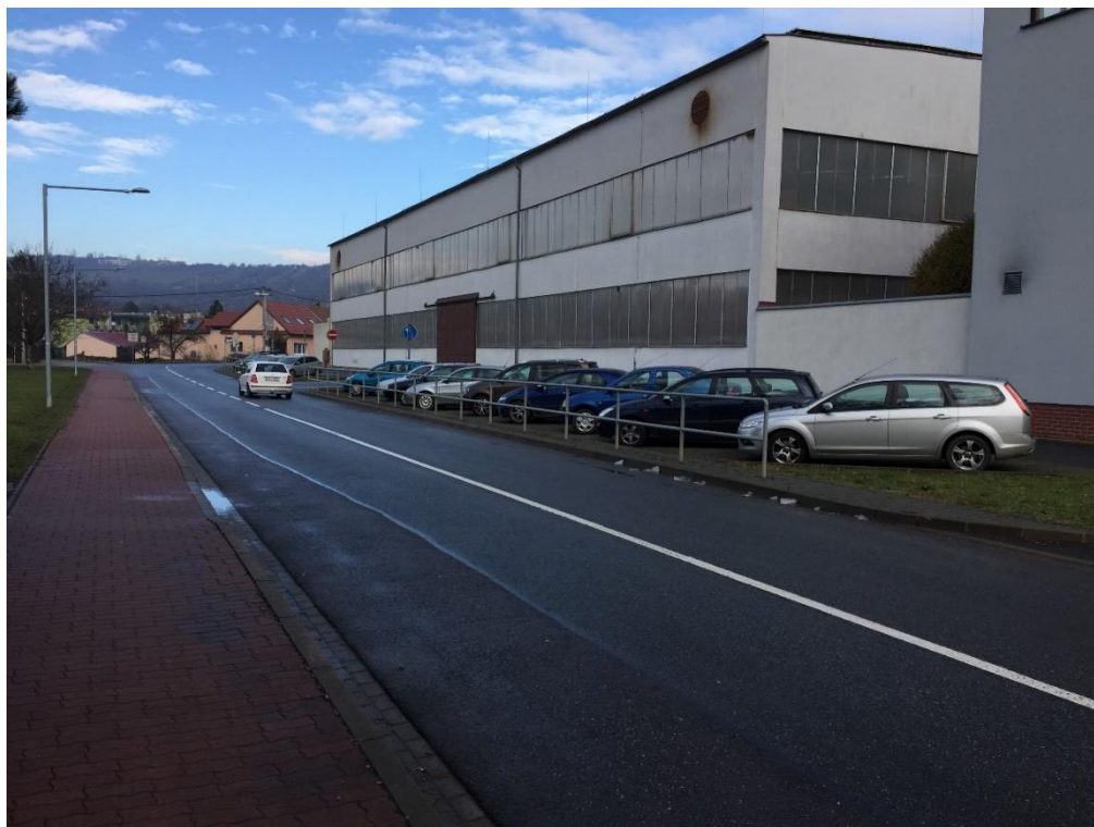
Obr. 28 – Parkovací plocha přilehlá k budově EST Stage Technology, Inc.
