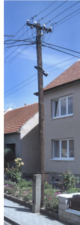
dřevěný stožár s betonovým soklem výšky 8 m
