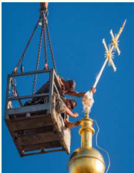
Oprava ohnutého křížku
